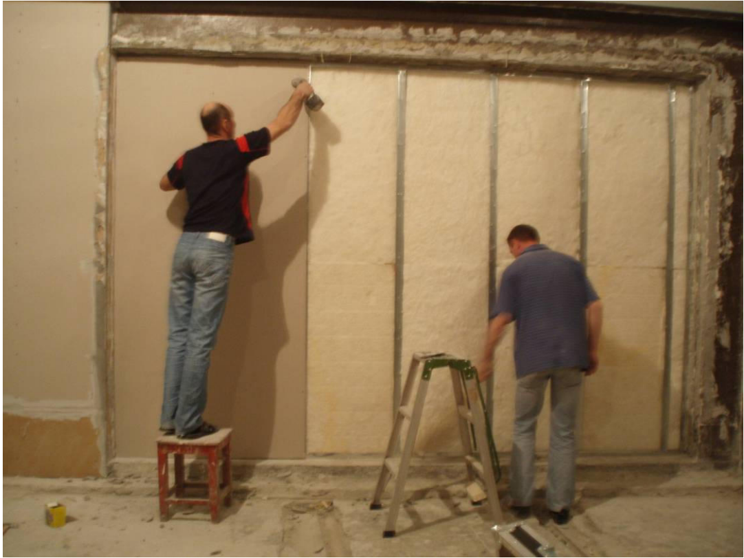
Рис.3. Монтаж перегородки № 3 в звукоизоляционных камерах (материал PureOne 34 PN).
