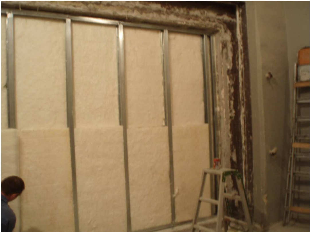
Рис.4. Размещение второго слоя материала PureOne 34 PN для конструкций перегородок № 5 и № 6.
