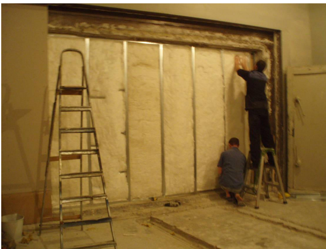
Рис.2. Монтаж перегородки № 1 в звукоизоляционных камерах (материал PureOne 37 RN).
